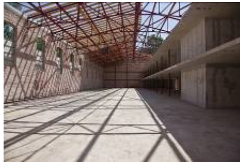
Slika 4 - Gradnja Laube, Stanje u srpnju 2010., Fotograf: Damir Žižić, © Lauba
