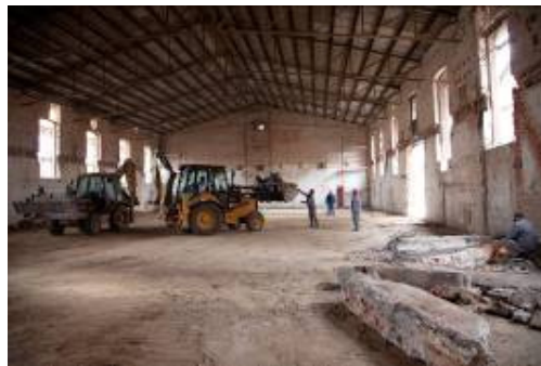
Slika 5 - Gradnja Laube, Stanje u veljači 2010., Fotograf: Damir Žižić, © Lauba
